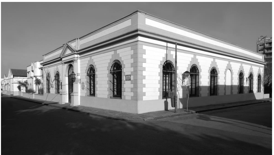
Sede de la Asamblea Representativa, tal como se ve en la actualidad. (Casa de la Cultura de Maldonado, Rafael Pérez del Puerto y Sarandí).
