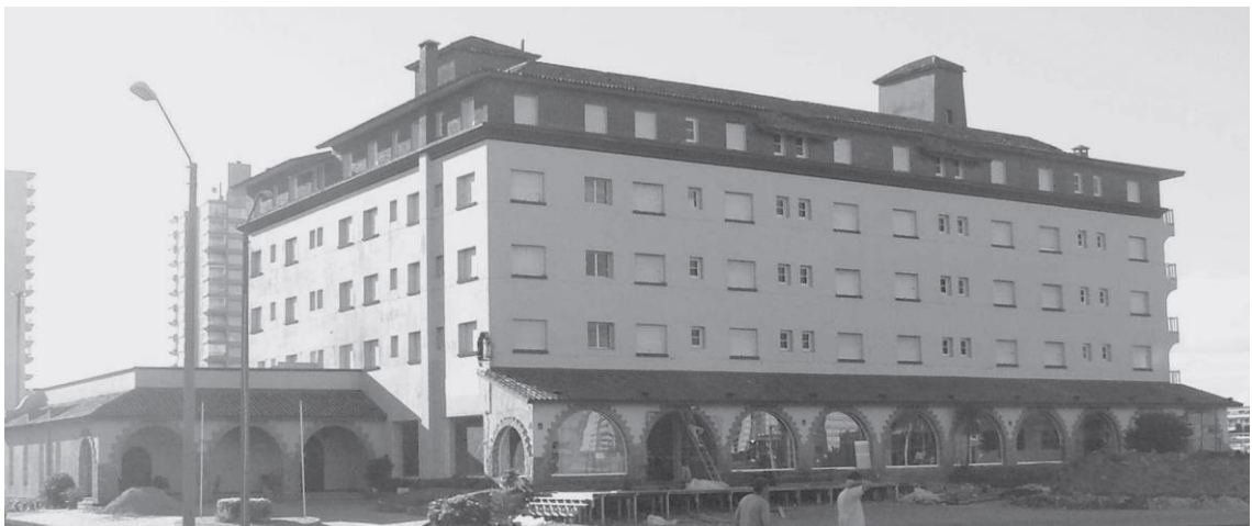
Estructura definitiva del hotel. (Fotografía aportada por el diario Correo de Punta del Este).
