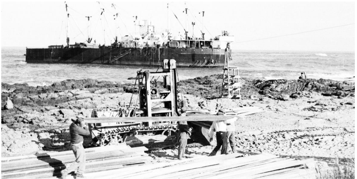
Oruga dispuesta como improvisado motor del aerocarril.
