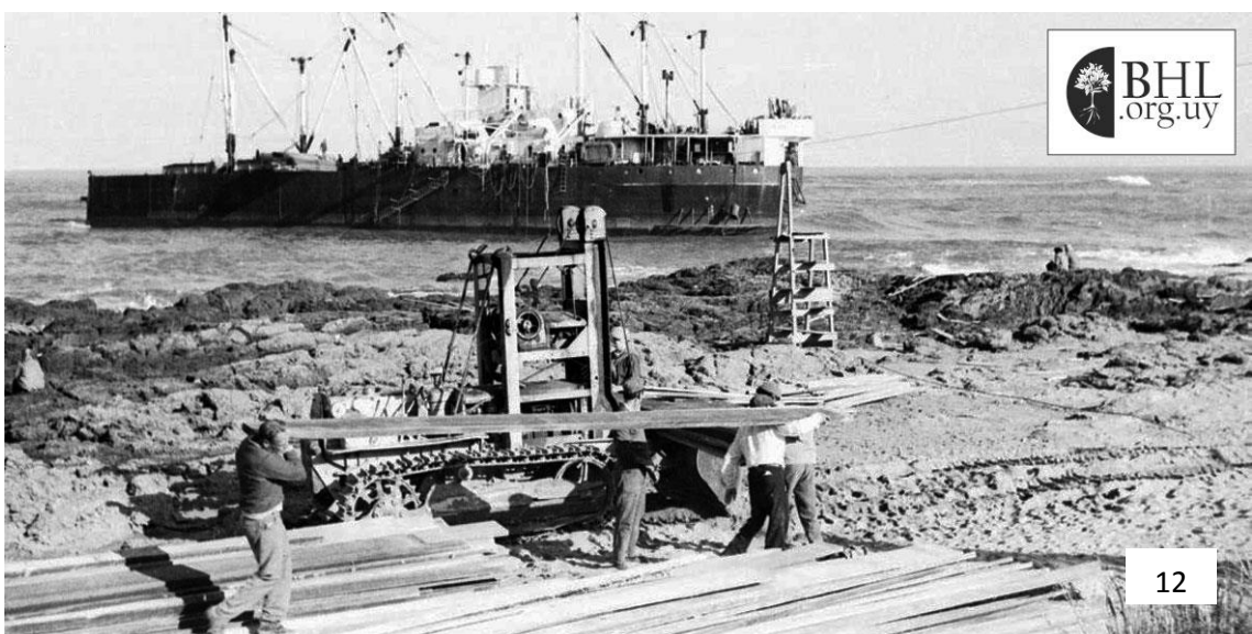
Oruga dispuesta como improvisado motor del aerocarril.
