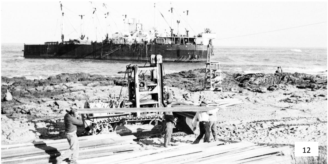
Oruga dispuesta como improvisado motor del aerocarril.
